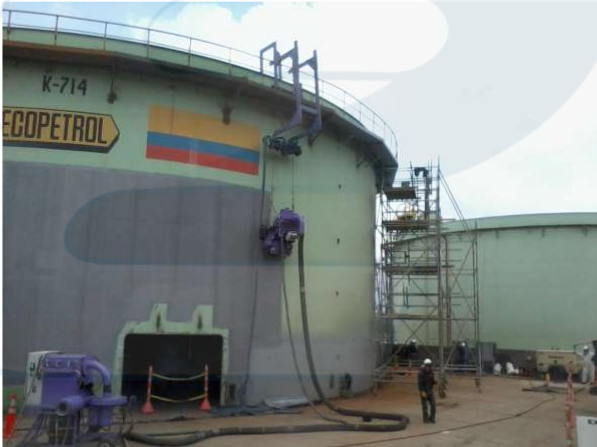
Utilizado para la limpieza interna de tanques con techo flotante.
