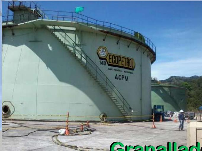
**DOS TANQUES COMPLETOS DE ALMACENAMIENTO DE PETROLEO DE 43.000 Barriles. – TAPA FLOTANTE Estación Puerto Salgar Ecopetrol Colombia - 2013**
